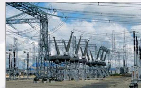
Подстанция 500 кВ Ново-Анжерская (Кемеровская обл.) ОРУ 500 кВ с применением баковых элегазовых выключателей. В 2010 году после проведения комплексной реконструкции в Кузбассе введена в эксплуатацию обновлённая узловая подстанция центральной Сибири – подстанция 500 кВ Ново-Анжерская.
