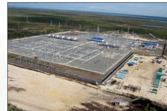
Подстанция 500 кВ Пересвет Общий вид площадки ПС Ввод подстанции Пересвет проектной мощностью 1002 МВА создал необходимые условия для присоединения к электрическим сетям потребителей нефте- и газодобычи Ханты-Мансийского автономного округа, привёл к увеличению пропускной способности Сургутского энергоузла.
