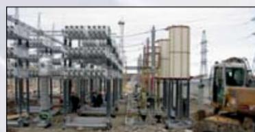
Подстанция 500 кВ Означенное. Монтаж БСК 220 кВ. Введённые в условиях выбытия генерации Саяно-Шушенской ГЭС в сверхсжатые сроки батареи статических конденсаторов (БСК) на подстанциях 500 кВ Означенное и 500 кВ Аллюминиевая к ОЗМ 2009-2010 позволили избежать угрозы ограничения потребителей электроэнергии, угрозы падения уровня напряжения в электросети и в целом повысили надёжность электроснабжения республик Хакасии и Тувы.
