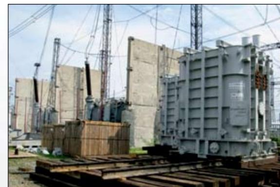
Подстанция 500 кВ Тюмень (Тюменская обл.) Установка новых фаз шинного шунтирующего реактора 500 кВ мощностью по 60 Мвар.
