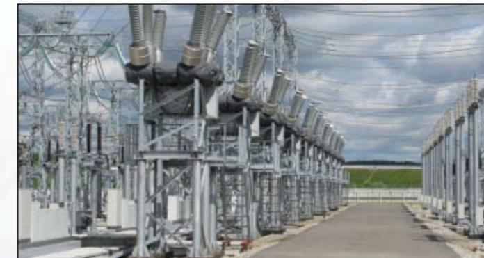
Подстанция 220 кВ Соболи (Пермский край), Баковые выключатели на ОРУ 110 кВ. На подстанции были установлены два новых автотрансформатора мощностью по 250 МВА, что позволило разгрузить эксплуатируемые более 25 лет перегруженные автотрансформаторы основного питающего центра Перми – подстанции 220 кВ Владимирская и существенно повысить надёжность электроснабжения Пермского региона.
