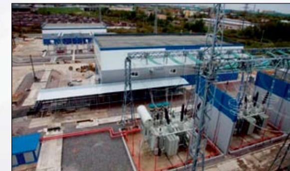
Подстанция 330 кВ Южная СПб АТ 330 кВ 2х200 МВА и здание КРУЭ 110 кВ Подстанция 330 кВ Южная обеспечивает электроснабжение шести районов Санкт-Петербурга и выдачу мощности Южной ТЭЦ. На подстанции возведены КРУЭ 110 и 330 кВ, введены два новых автотрансформатора 330/110 кВ. После демонтажа ОРУ 330 кВ начнется монтаж КРУЭ 220 кВ.
