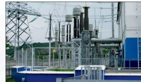
Подстанция 330 кВ Машук Заходы ВЛ 330 кВ в КРУЭ 330 кВ. Комплексная реконструкция подстанции 330 кВ Машук была реализована на действующей площадке подстанции. При реконструкции было впервые применено КРУЭ 330 кВ. Подстанция является ключевым объектом электроснабжения курортов и санаториев Кавказских минеральных вод.
