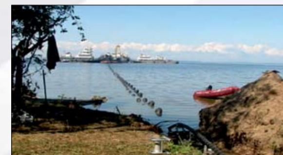
Прокладка кабеля 35 кВ на о. Валаам В соответствии с Поручением Президента Российской Федерации произведены работы по реконструкции подстанции 220 кВ Ляскеля (Республика Карелия), строительству новой подстанции 35 кВ Валаам и двухцепной кабельно-воздушной линии электропередачи 35 кВ Ляскеля – Валаам протяженностью 50 км (протяженность кабельной линии по дну Ладожского озера – 24,7 км).
