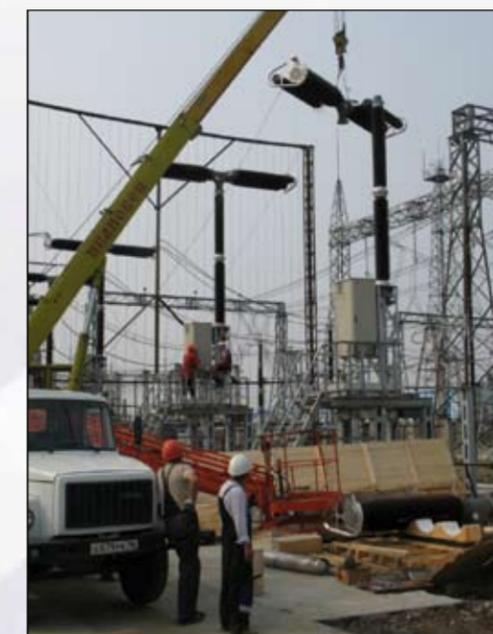
Монтаж выключателя 500 кВ в цепи новой высоковольтной линии Северная-БАЗ на подстанции 500 кВ БАЗ (Свердловская обл.)
