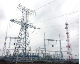
Реконструкция ПС 220 кВ НПС-19 (для ТП энергопринимающих устройств ОАО «Транснефть-Восток») с увеличением трансформаторной мощности на 30 МВА до 80 МВА
