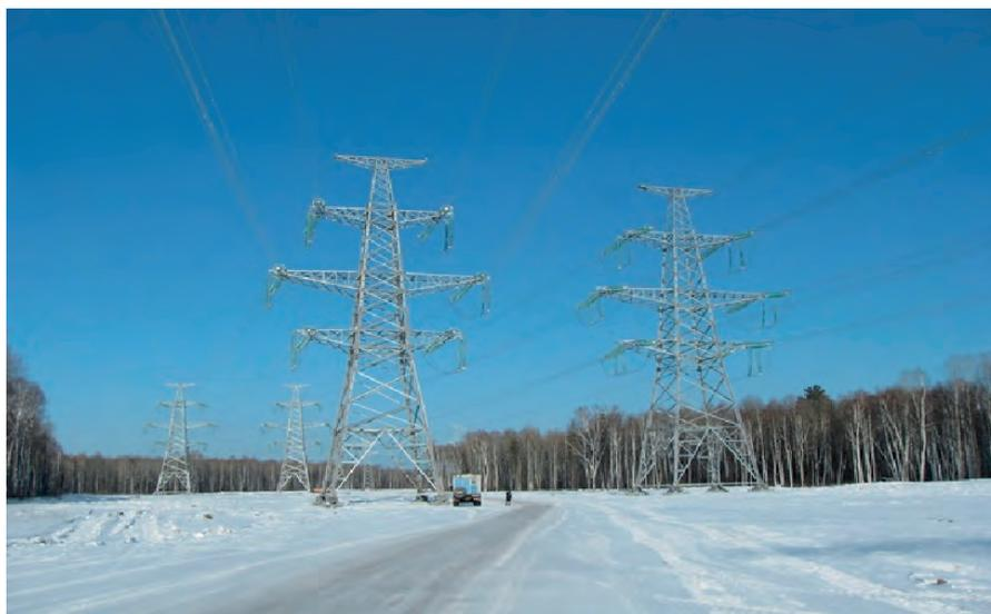
НИОКР ПАО «ФСК ЕЭС» «Проектирование, изготовление, строительство и опытно-промышленная эксплуатация опытных участков перспективных ВЛ 500 кВ с применением высотных и эстетических опор». Данное техническое решение позволило свести к технологическому минимуму полосу отвода для четырех ВЛ 500 кВ при параллельном следовании и устроить воздушную линию в стесненных условиях трассы, насыщенной объектами нефтегазовой
